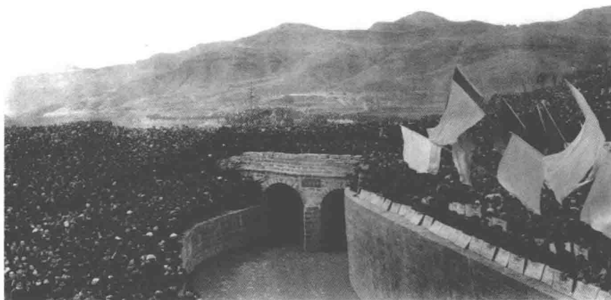
修建完成的红旗渠。
