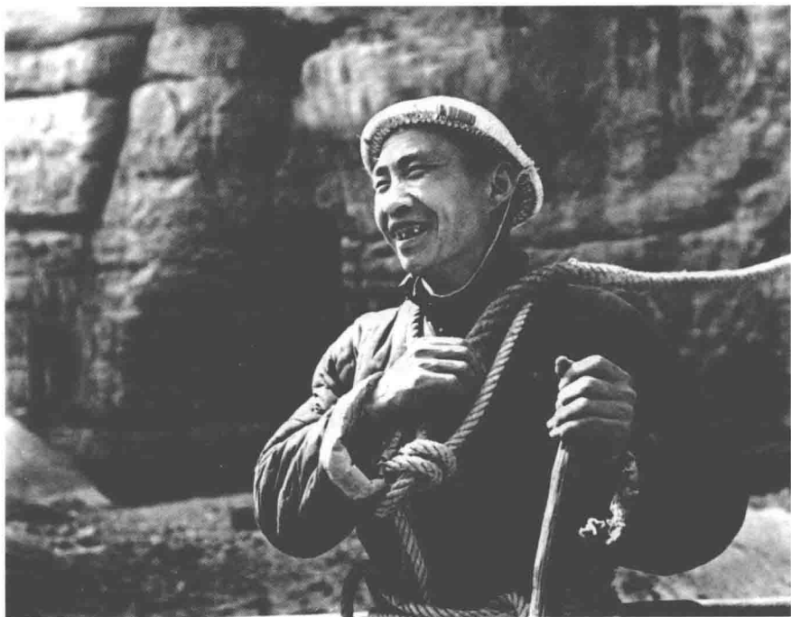
任羊成在修建红旗渠的施工现场。（资料照片 新华社发）
